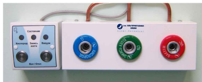
Размещение газовых консолей на стене Вид АА
